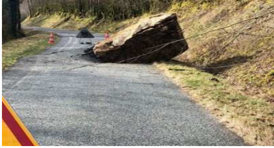
chute de bloc sur la RD59 entre Jura Ain en 2019
