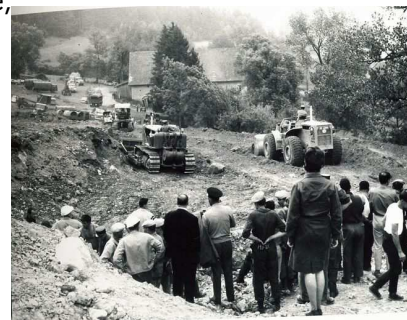
Eboulement d'une mine de calcaire d'une cimenterie au Mont Rivel à Champagnole en 1964
